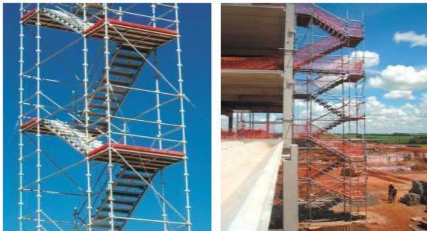
**Figura 2.** Escaleras metálicas de acceso
