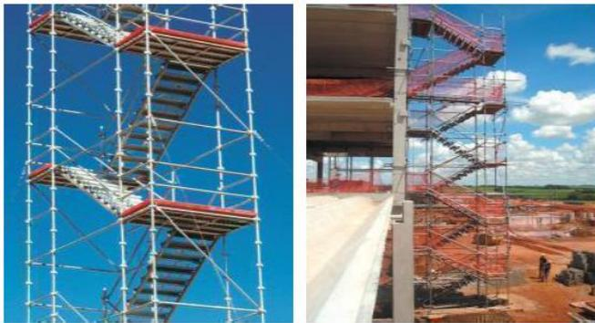
**Figura 2.** Escaleras metálicas de acceso
