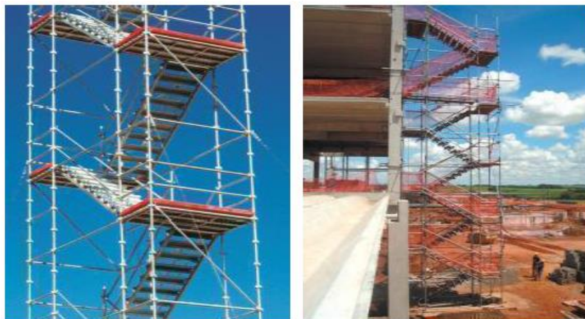
Figura 2. Escaleras metálicas de acceso
