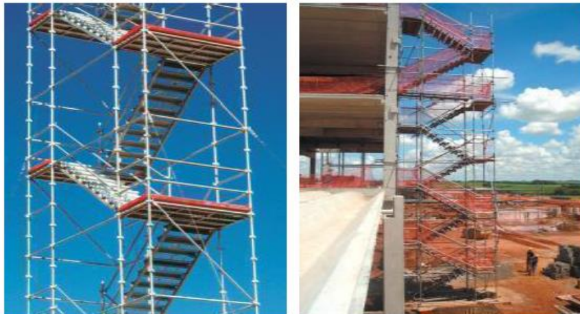
Figura 2. Escaleras metálicas de acceso
