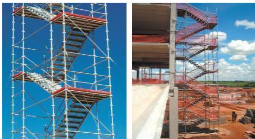
Figura 2. Escaleras metálicas de acceso
