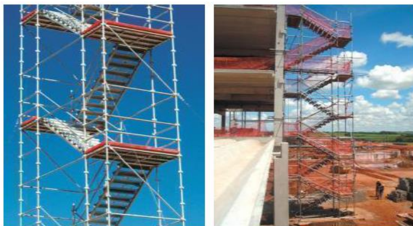
Figura 2. Escaleras metálicas de acceso
