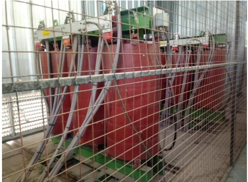
Subestación transformadora – Trafos de 1000 KVA
