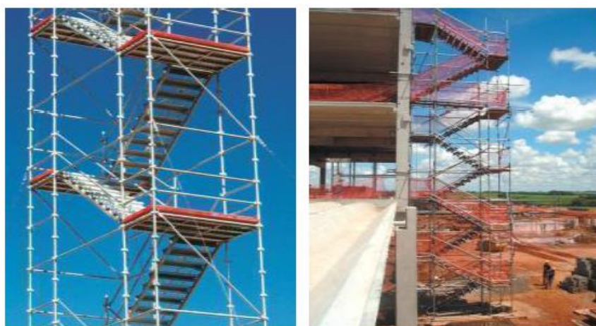
Figura 2. Escaleras metálicas de acceso
