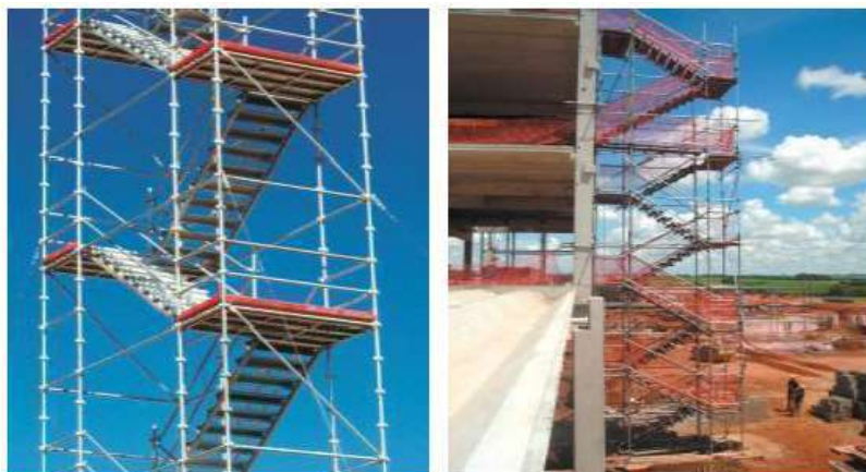
Figura 2. Escaleras metálicas de acceso.
